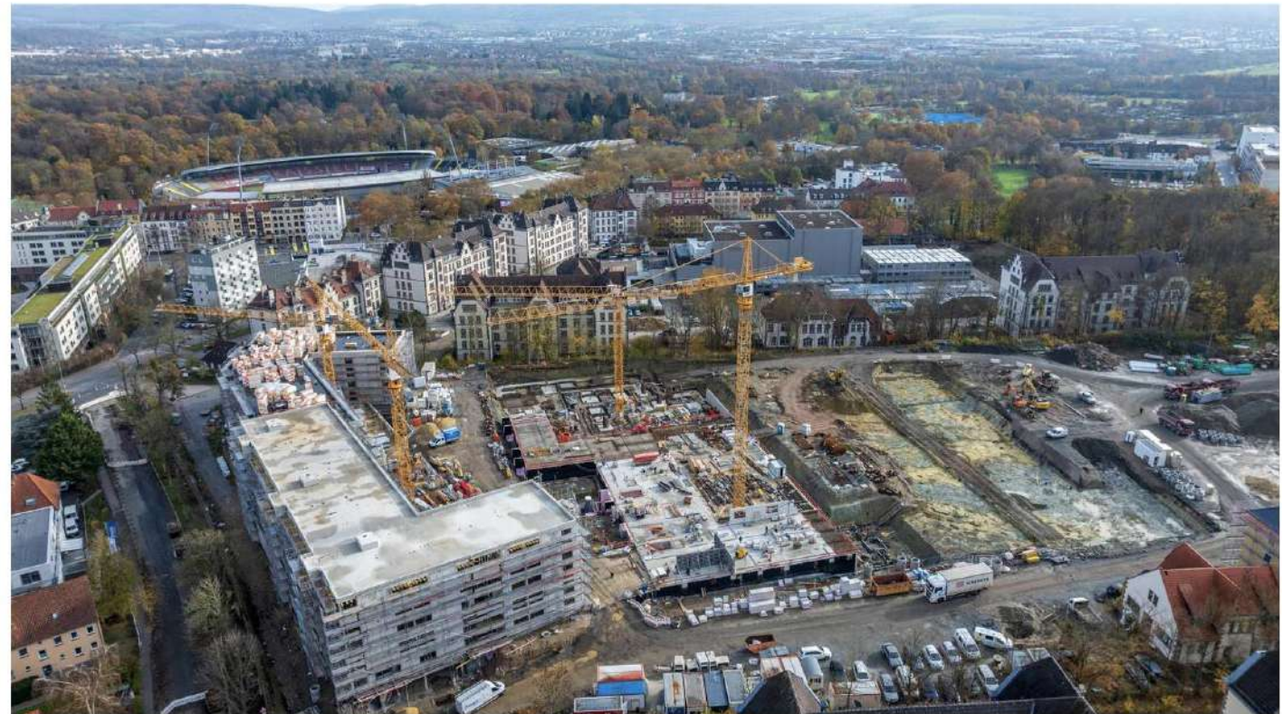
Es ist viel passiert: Im Vordergrund sind die ersten beiden Gebäuderiegel zu erkennen. Der erste ist bereits im Rohbau abgeschlossen. Rechts wird die Baugrube für das Seniorenwohnen ausgehoben. © Fischer, Andreas
