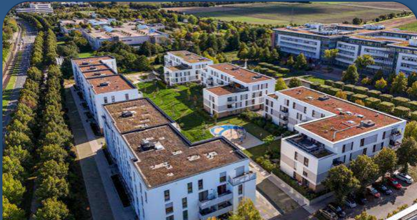
Europakarree I (bereits fertiggestellt)
