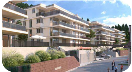
Lahr Altenberg 44 Neubauwohnungen
