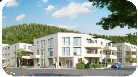
Lahr Langenhard 92 Neubauwohnungen
